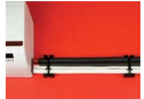
Уложите трассу и закрепите ее при помощи держателей с хомутом
