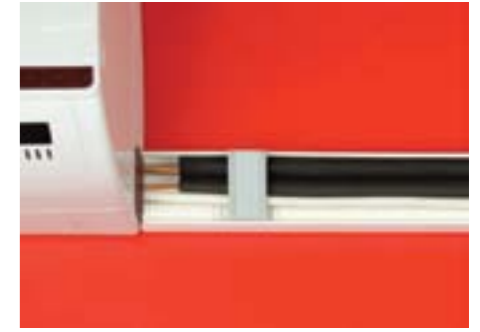
Закрепите трассу в основании короба при помощи фиксирующих скоб
