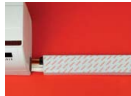
Закройте смонтированную трассу крышкой
