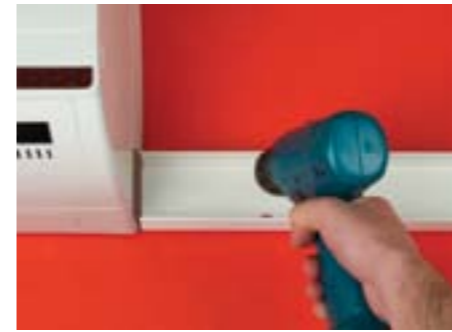
Закрепите основание короба на стене
